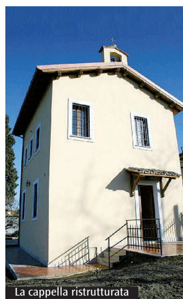
La cappella ristrutturata
