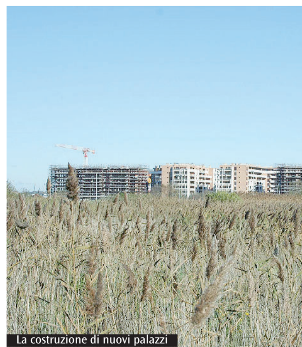
La costruzione di nuovi palazzi
