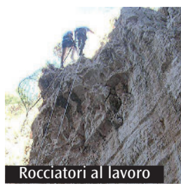
Rocciatori al lavoro
