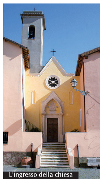
L'ingresso della chiesa
