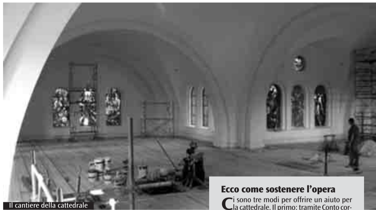
Il cantiere della cattedrale
